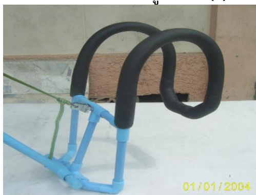
(7) ติดตั้งเสร็จแล้ว
