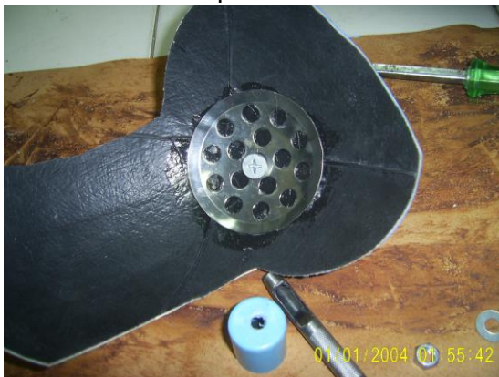
ร่อนนํ้ากับแผ่นฝาครอบท่อ/ทากาวยาง
